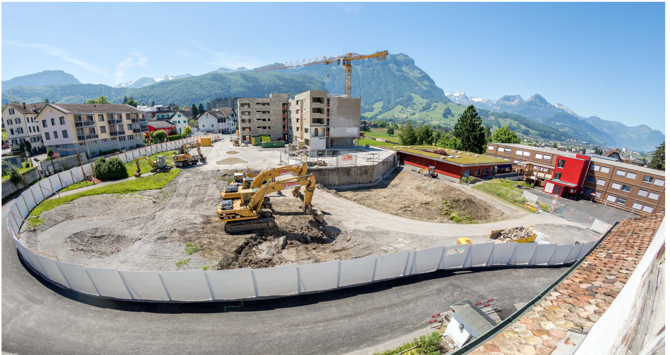
Das Bild wurde am 11. Juni 2017 vom historischen Haus Acher aus gemacht. Es zeigt das auf «Rohbauniveau» zurückgebaute Alterszentrum. Rechts aussen ist der Wohnpavillon zu sehen. Hier wohnen die Senioren/-innen während der Bauzeit in Komfortzimmern und werden bestens betreut. Dazwischen liegt das «Haus Franziskus» für demenzerkrankte Menschen.
