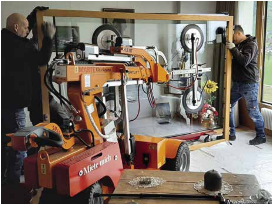
Zum Wechseln der Fenster wird der «Smartlift» eingesetzt (siehe auch Bild unten).
